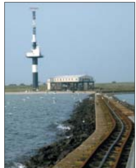
Beobachtungspunkte: Radarturm, Unterkunftsgelände des Wasser- und Schiffsamtes Wilhelmshaven, Bühne C. Foto: Clemens
