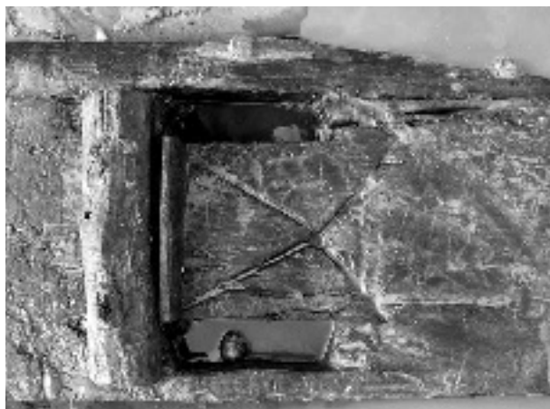
Abb. 9: Die Mastspur mit den Entwässerungsrillen. Bei der Mastspur die Aufnahmen für die Stützwangen, in denen noch die Reste der starken Bronzebolzen zu erkennen sind, dahinter das aufgedübelte Querholz. Blick von Steuerbord (der Bug befindet sich rechts).
