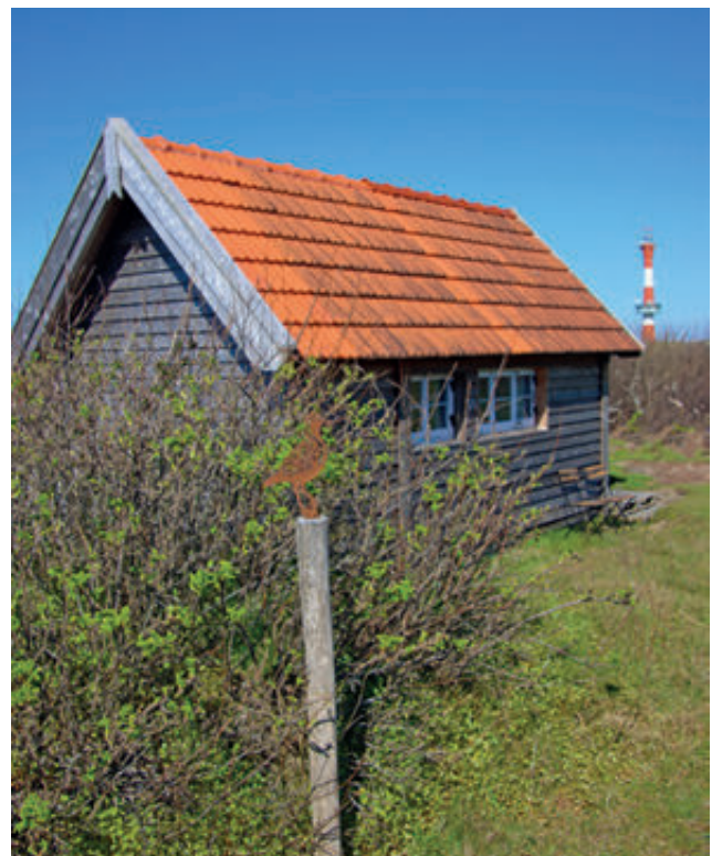
Die renovierte Weststation heute. Ein Großteil der alten Dachziegel wurde wiederverwendet, abgängige Dachziegel wurden ersetzt. Deshalb die unterschiedliche Farbe im Dach. Foto: Mathias Heckroth
