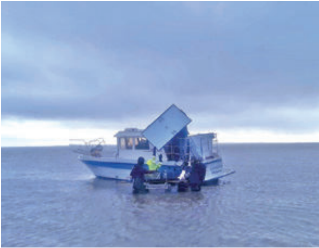
Abb. 1: Entladen der Solarmodule im Watt vor Mellum. Foto: Jonas Frey
