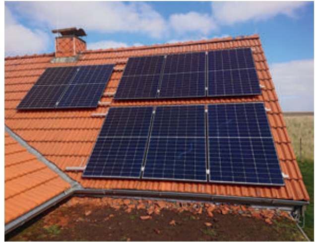
Abb. 2: Fertig montierte Solarmodule auf dem Dach. Foto: Stefan Czybik
