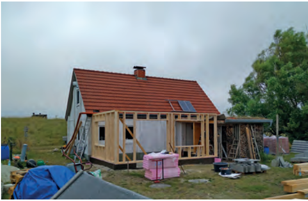
Abb. 4: Die Baustelle einen Tag nach Anlandung des Schiffes. Foto: Jonas Frey
