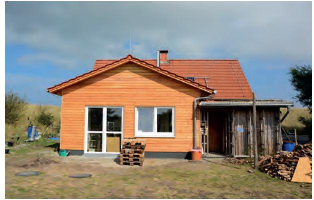
Abb. 5: Von außen ist der Anbau fertig. Foto: Stefan Czybik
